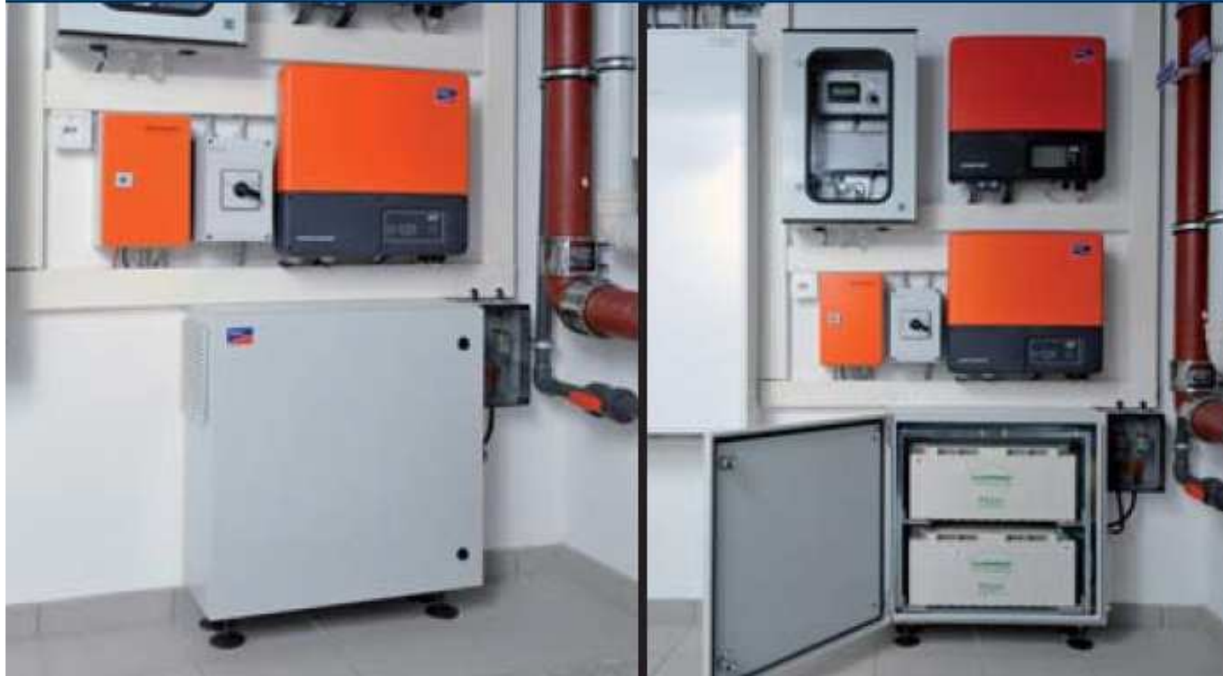
Abb. 4: Backup-System mit Batteriespeicher
